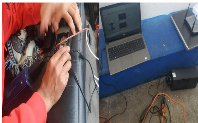
Figura 2. 22 Instalación y calibración inversor y Raspberry
