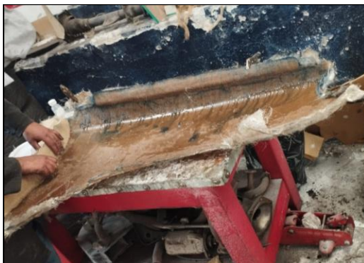
Figura 2.32 Aplicación de fibra tejida en el molde
