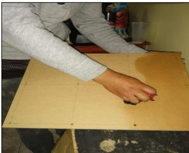
Figura 2.17 Aplicación de cera desmoldante
