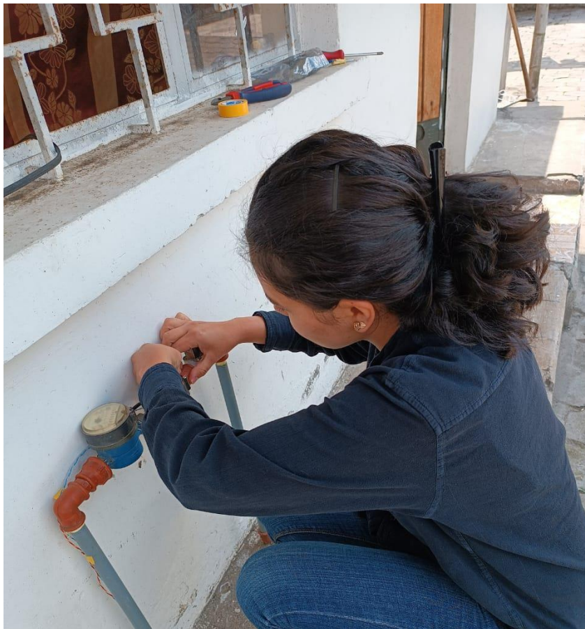
Figura 4. Instalación del sensor y electroválvula en uno de los domicilios de los usuarios
