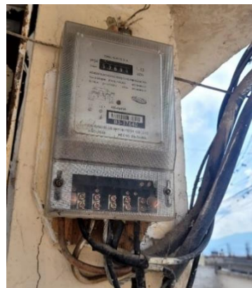
Figura 2. 6: Medidor eléctrico
