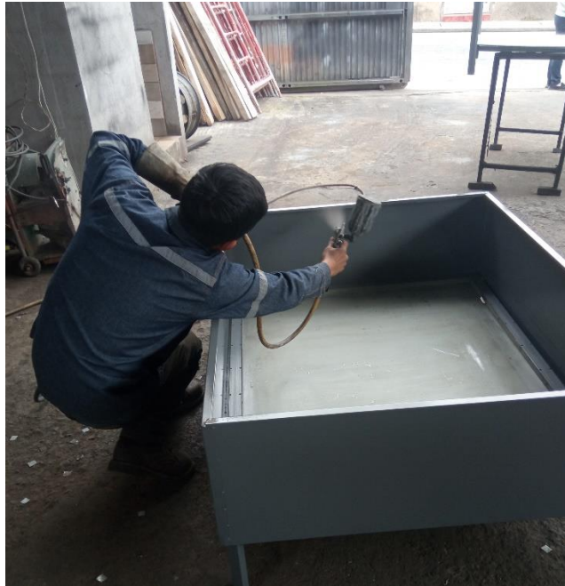
Figura 97 Pintado del bastidor Fuente: Autoría Propia
