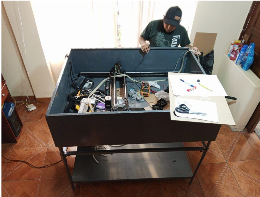
Figura 105 Cableado del sistema CNC Fuente: Autoría propia
