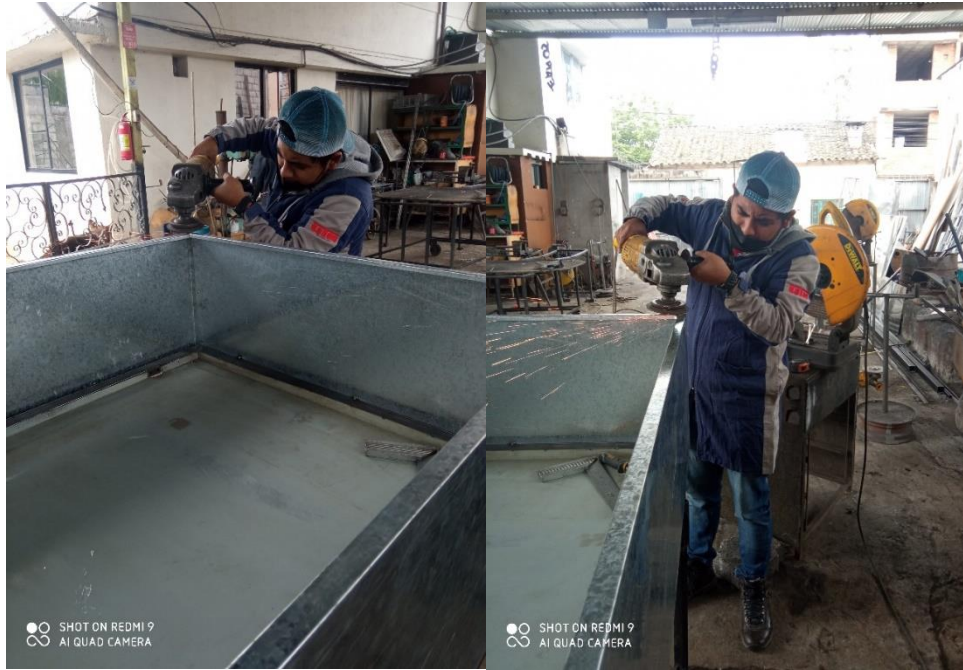
Figura 95 Construcción del área de trabajo del bastidor Fuente: Autoría propia
