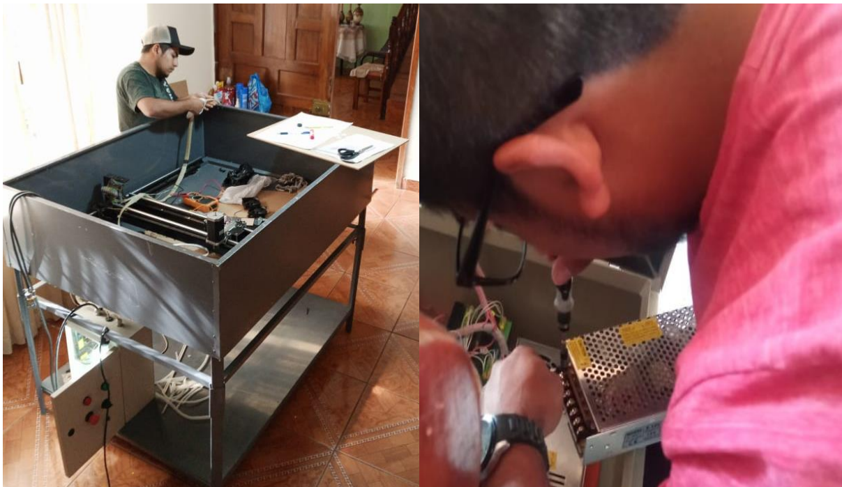
Figura 51 Ensamble y etiquetado del tablero de control Fuente: Propia Autoría
