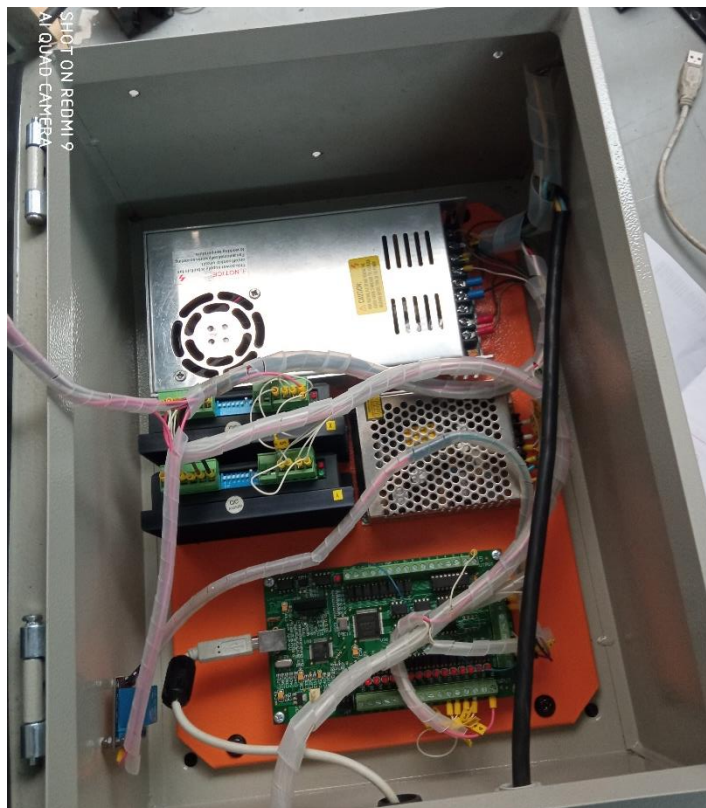
Figura 104 Montaje del sistema eléctrico Fuente: Autoría propia
