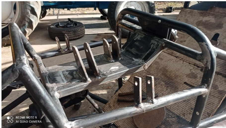
Figura 4. 9 Soldadura de los anclajes del amortiguador
