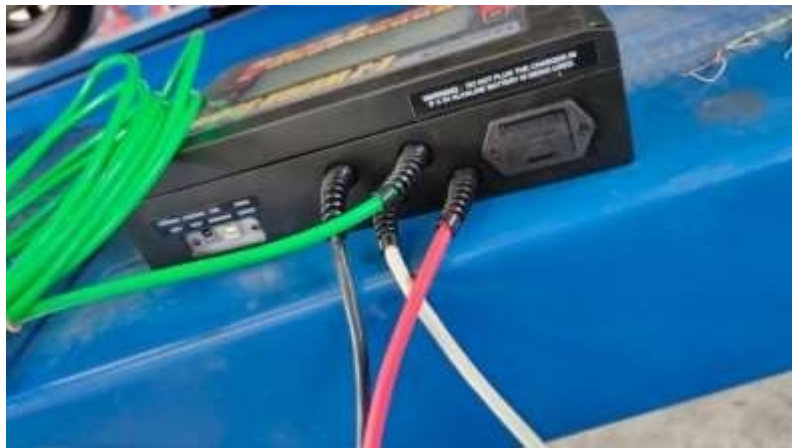
Figura 2.14 Instalación de cables de balanzas
