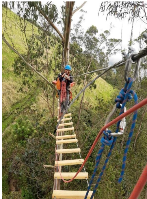
Figura 27: Puente colgante en construcción Fuente: Jorge Duque - Hillary Resort
