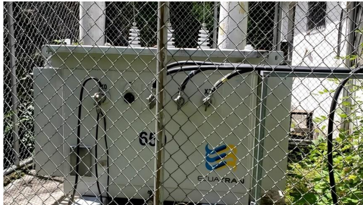
Fig. 18 Transformador elevador
