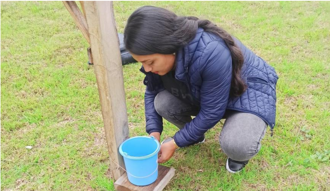
Anexo 2. Instalación de instrumentos para medir la precipitación.
