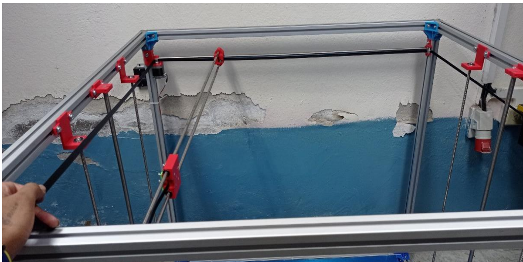
Figura 3.4 Montaje de las correas que mueven los ejes
