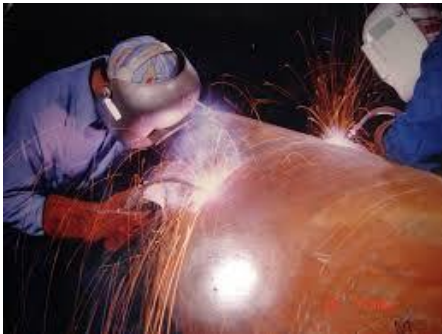
Figura 10 Soldadura de oleoductos (Lescam, 2011)
