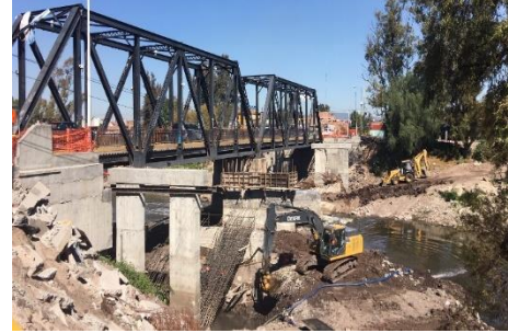
Figura 4 Construcción de puentes (Sicom, 2018)
