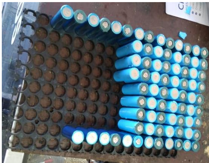
Figura 15 Instalación de las celdas en los separadores
