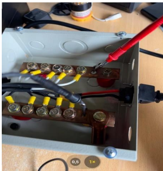
Figura 21 Conexión en paralelo de baterías de litio
