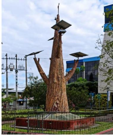
Fig. 11 Árbol solar fotovoltaico autónomo con almacenamiento de energía
