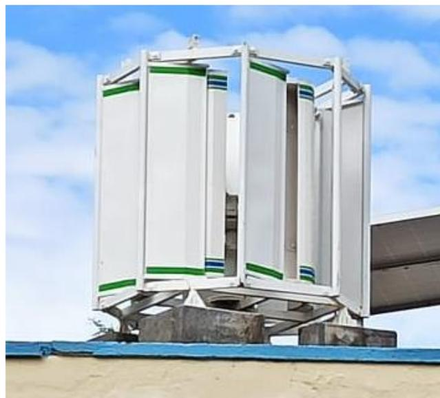
Fig. 13 Microsistema de generación eólica integrado a la red
