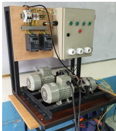
Fig. 57. Instauración de circuito de fuerza
