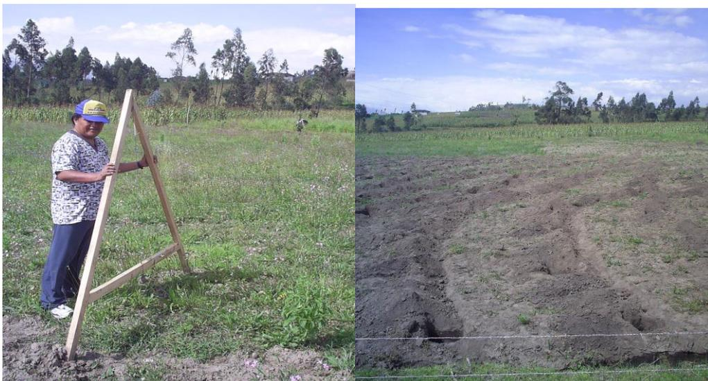
**Fotografía.5 Zanjas de desviación implantadas en la parcela integral.**
