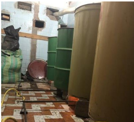
Tanques dentro del área de pasteurización
