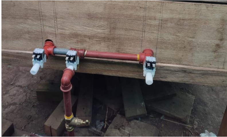
Figura 57 Perforaciones para tubería
