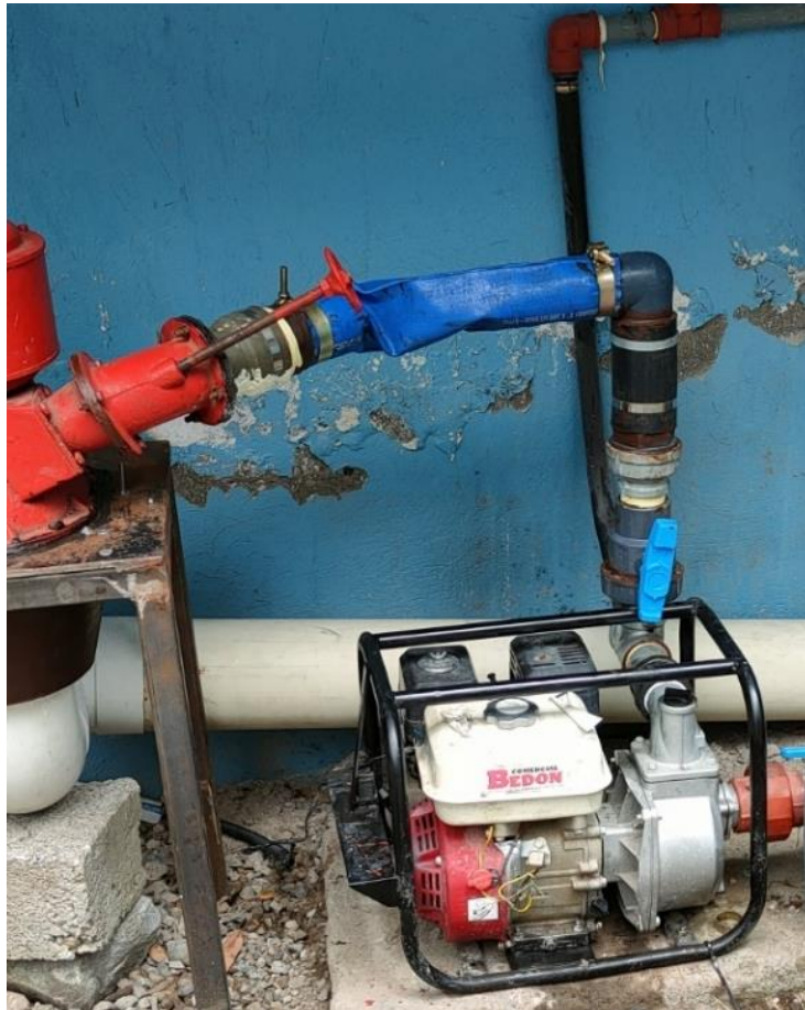
FIGURA 35 INSTALACIÓN DEL CONDUCTO DE AGUA DESDE LA MOTOBOMBA HASTA EL GENERADOR (FUENTE: AUTOR)
