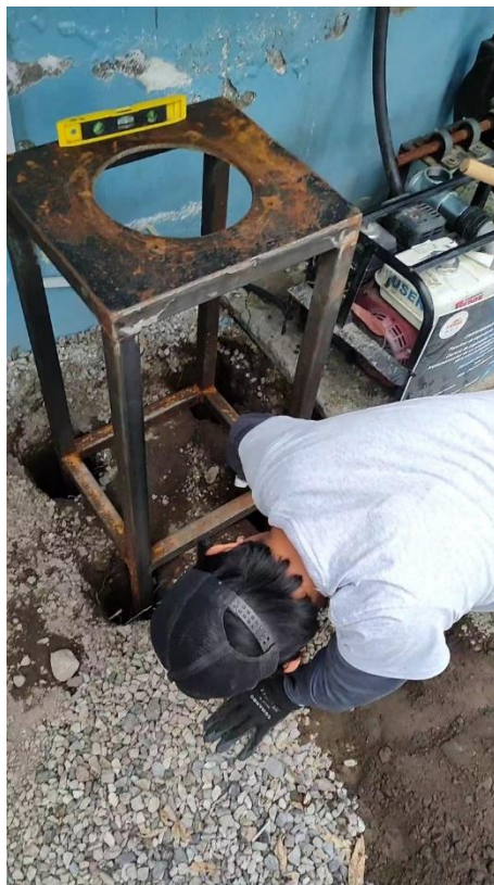
FIGURA 28 INSTALACIÓN DE LA BASE DEL GENERADOR (FUENTE: AUTOR)
