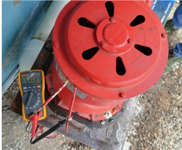
FIGURA 38 PRUEBA CON MEDICIÓN DE 117,3 VOLTIOS (FUENTE: AUTOR)
