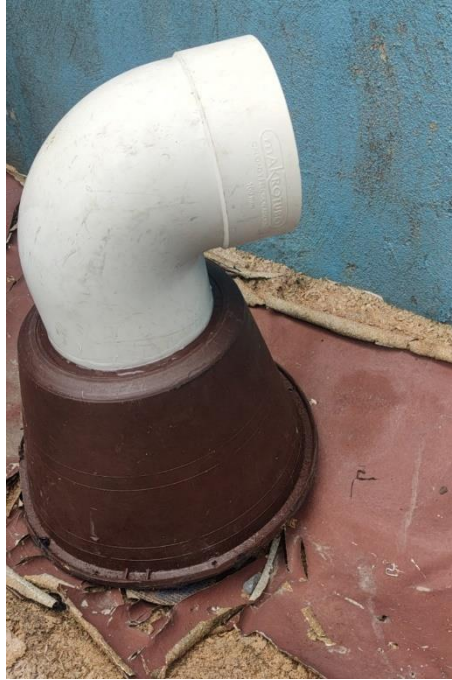
FIGURA 33 ACOPLE DE TUBERÍA PVC AL RECIPIENTE PARA SALIDA DE AGUA DEL GENERADOR (FUENTE: AUTOR)
