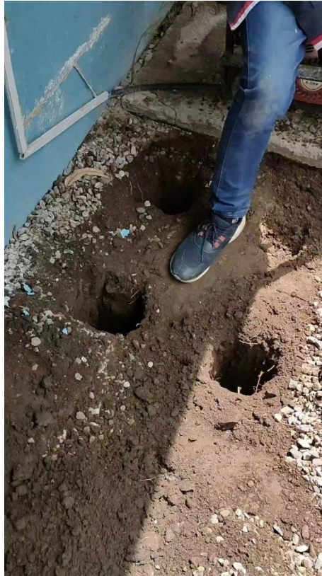
FIGURA 27 PREPARACIÓN DEL SUELO PARA MONTAJE DE LA BASE DEL GENERADOR (FUENTE: AUTOR)
