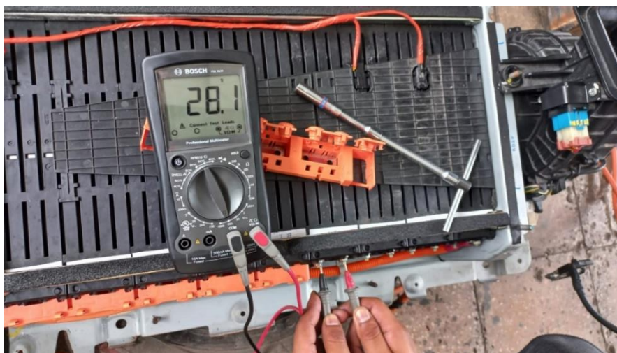
Figura 2.32 Medición de la tensión individual de cada módulo de la batería HV
