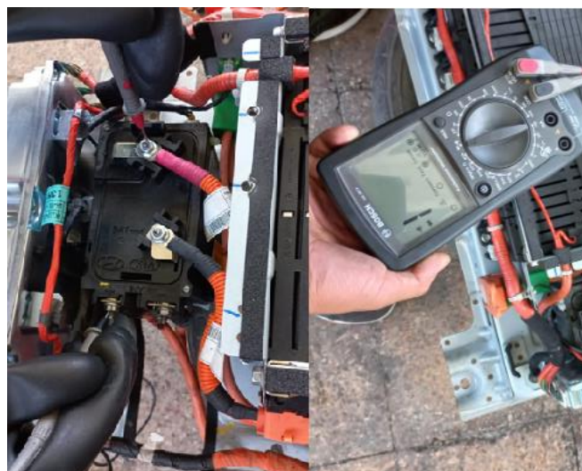
Figura 3.12 Diagnóstico del relé de precarga
