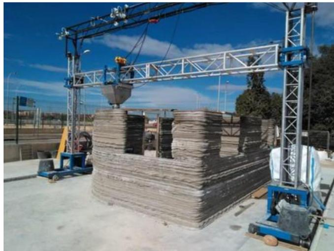
*Figura 2.2. Impresión de una vivienda aplicando impresión 3D [10].*
