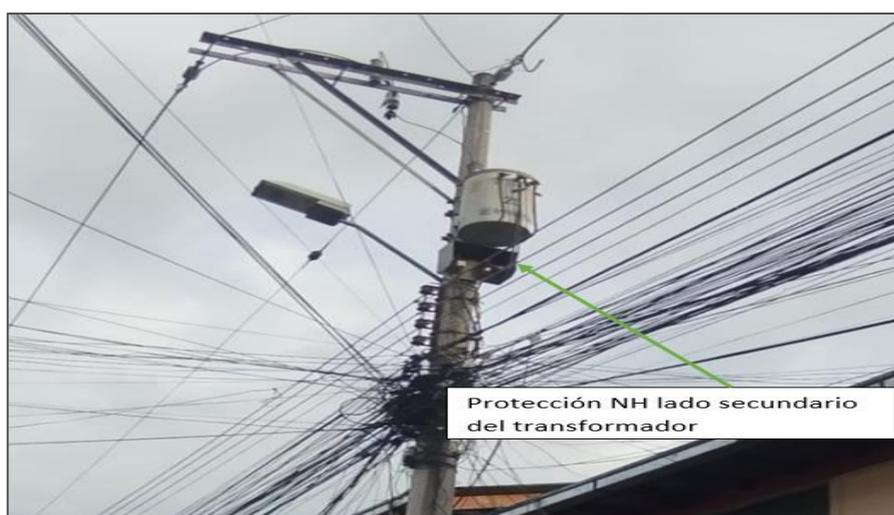
Figura 17 Protección lado secundario del transformador.
