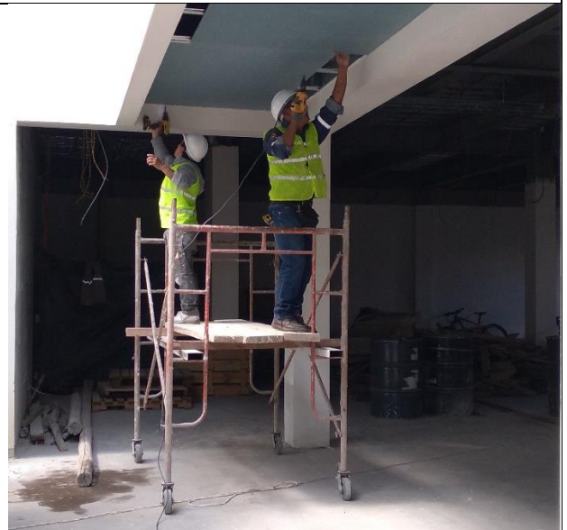
Imagen 4.- Técnicos de techos
