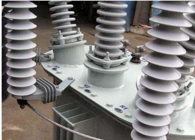
Figura 4. Pararrayos Auto valvulares en sistemas de transformación
