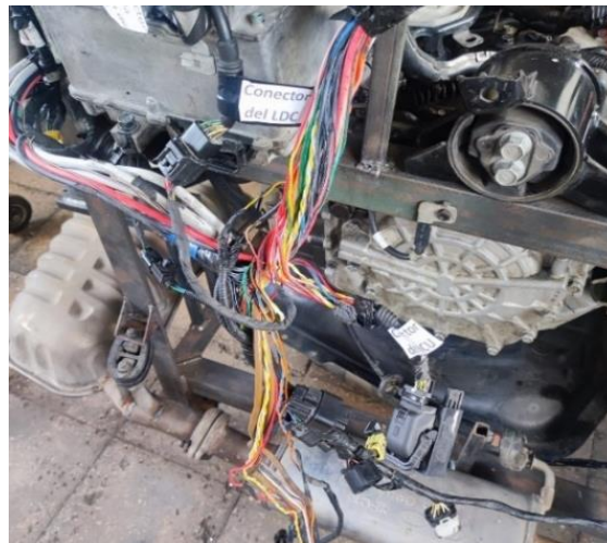
Figura 4.40 Cables del HCU
