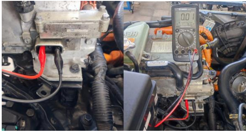
Anexo 5 figura 19 verificación de voltaje en el inversor
