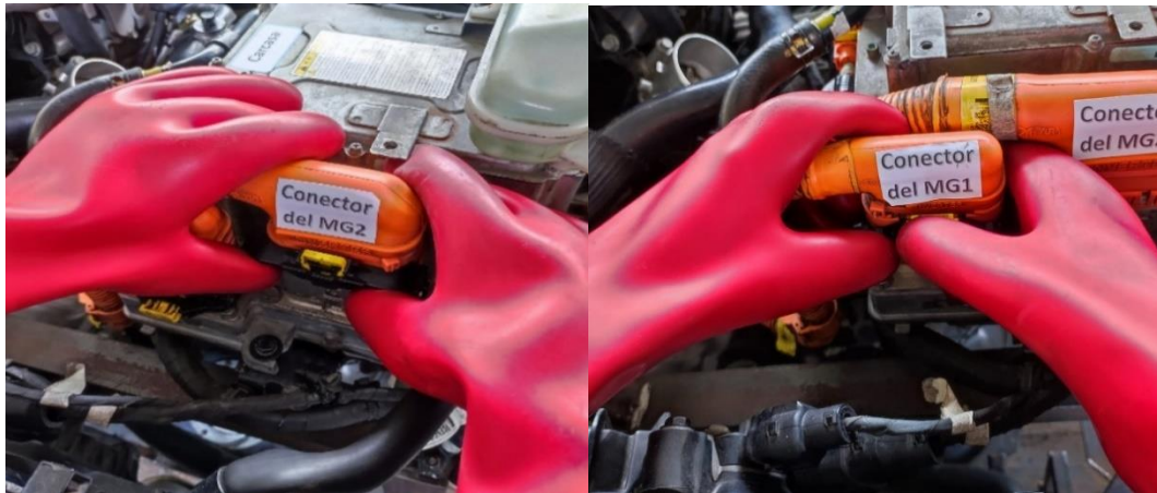
Anexo 5 figura 14 Conectores de los moto generadores
