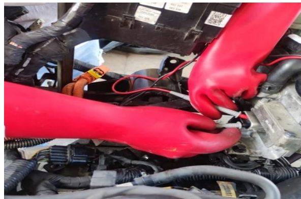
Figura 5 figura 18 Conector de la batería híbrida en el inversor
