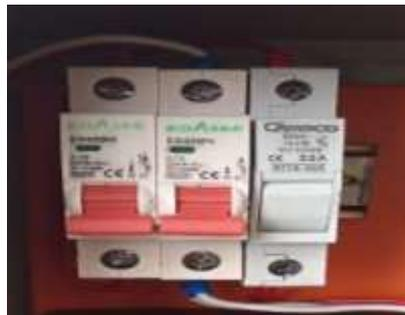
Fig.12. Elementos de protección del banco de pruebas
