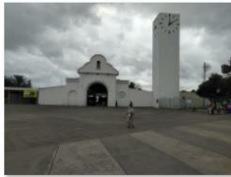
Terminal terrestre de Ibarra
