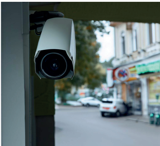
Figura 35 Cámara de seguridad instalada en la calle de la farmacia
