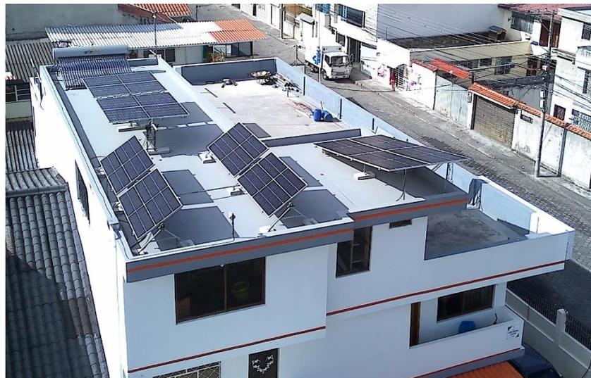
Los paneles solares cuentan con una orientación ESTE-OESTE con una inclinación de 45° con respecto al eje horizontal, sin embargo, la orientación cambia dependiendo de la ubicación del sol, este movimiento es posible gracias a que el sistema cuenta con un sistema
