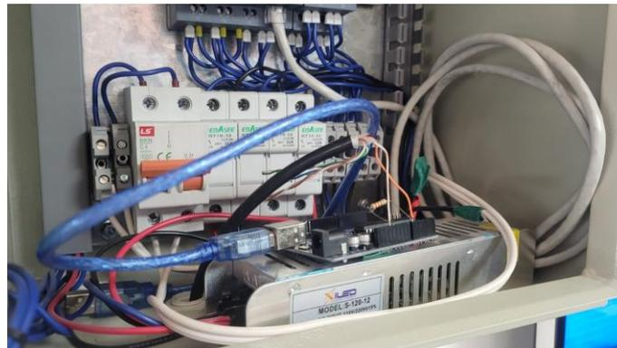
La señal de temperatura es transmitida a través de un conductor que, conecta el sensor de temperatura ubicado sobre la superficie de las placas fotovoltaicas (tal y como se observa en la Figura 27 y en la Figura 31) con la placa de Arduino, el conductor va desde las placas fotovoltaicas, pasa por una caja de conexiones ubicada en la terraza del inmueble (Figura 28) para finalmente llegar al tablero de control mostrado en la Figura 26.
