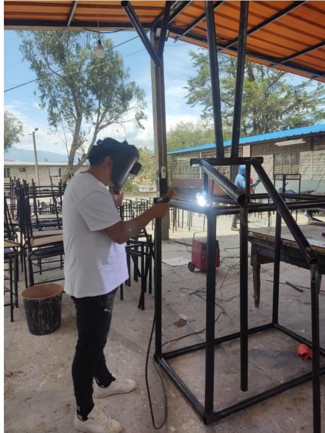
Figura 47. Soldadura del tubo galvanizado para la estructura
