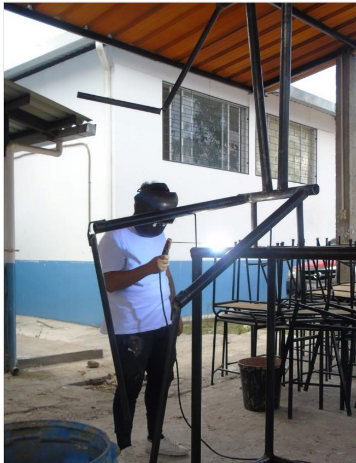
Figura 19. Soldadura de tubo galvanizado
