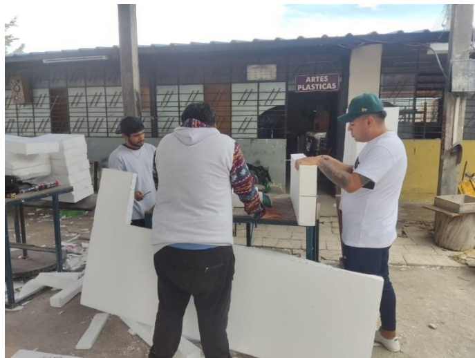
Figura 49. construcción de las piezas de espumaflex
