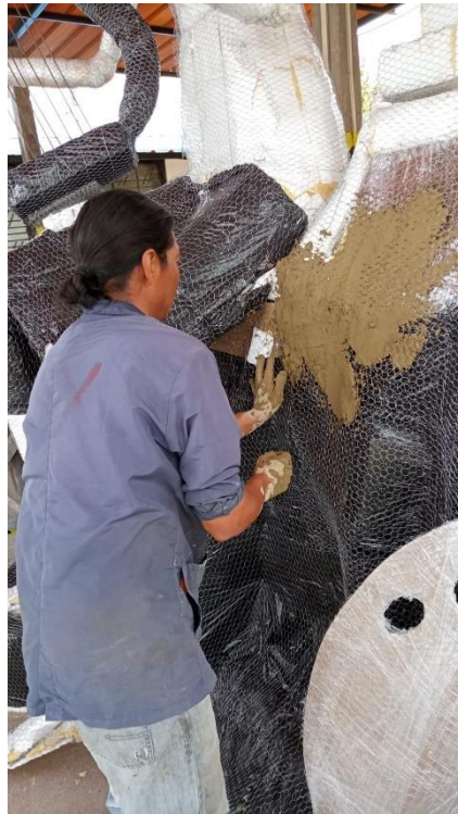
Figura 54. Relleno de la estructura con mortero
