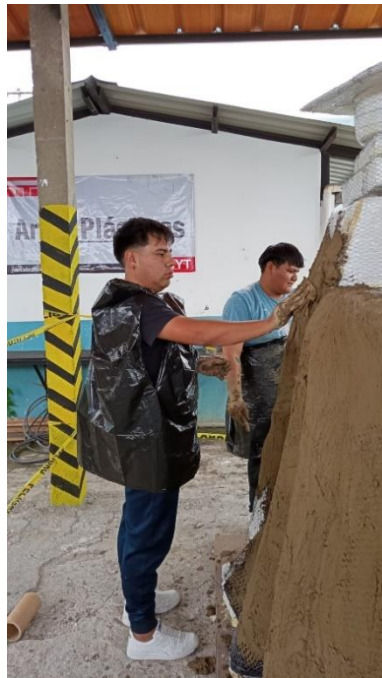
Figura 55. Aplicación primera capa de mortero
