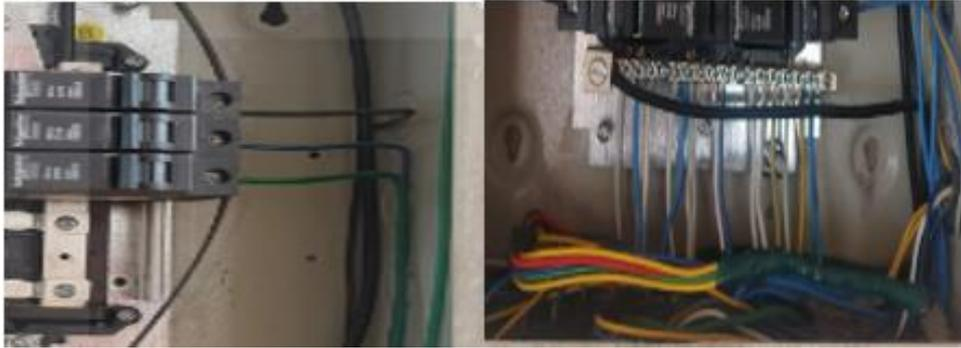
Fig. 2.12 Estado de los conductores del establecimiento
