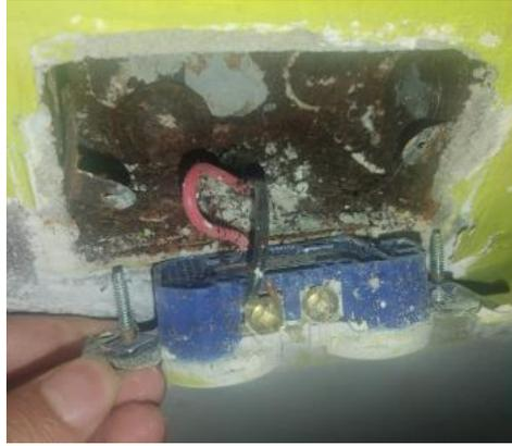
Fig. 2.14 Tomacorriente sin conexión a tierra
