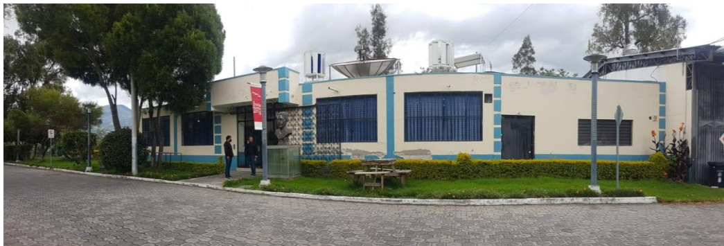
Figura 19 Edificio de la Carrera de Electricidad.
