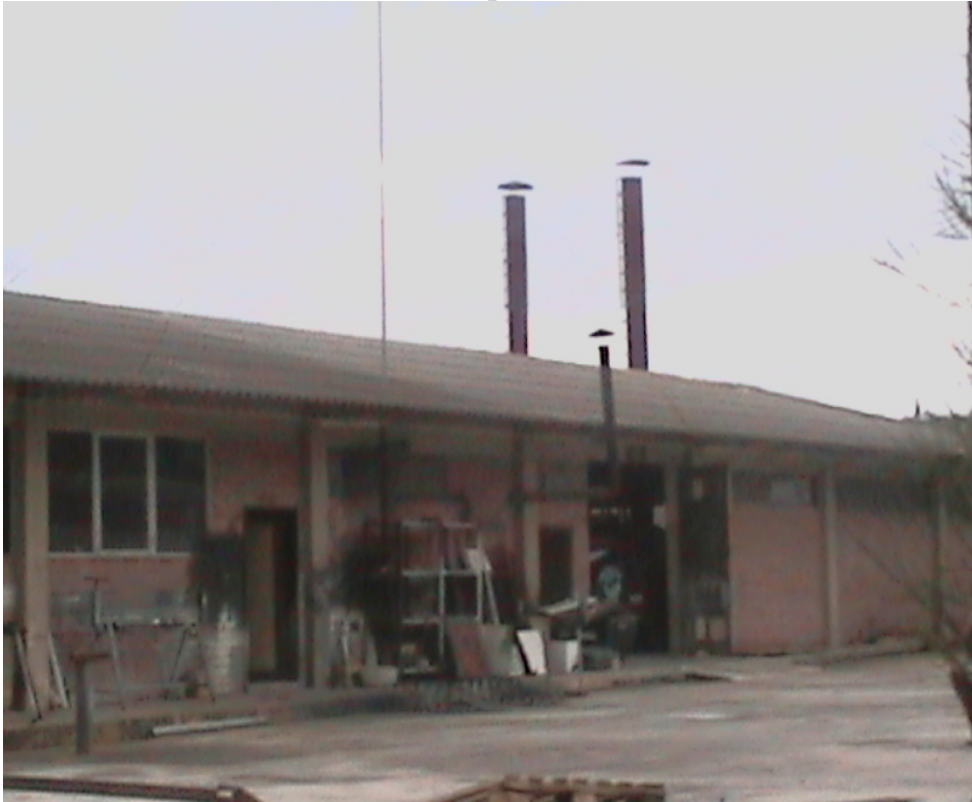
Foto 1: Hospital de IESS
