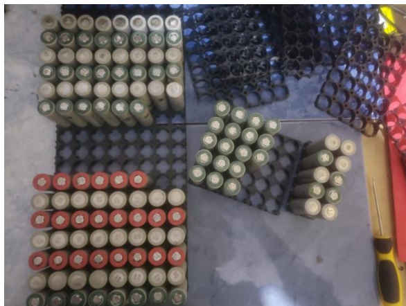
Figura 2.5 Construcción del Banco de Baterías
