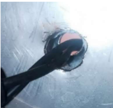
Fig. 50. Extensión de la perforación.
