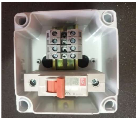
Fig. 52. Montaje de borneras y disyuntor.
