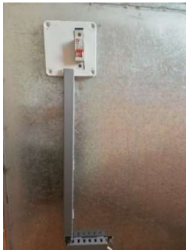
Fig. 56. Cajetín y canaletas, vista posterior carcasa externa.
