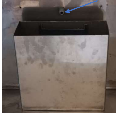
Fig. 47. Recipiente y perforación para salida de cables.
