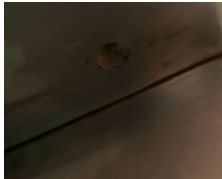
Fig. 48. Perforación inferior de la cámara interna hacia el gabinete de control.
