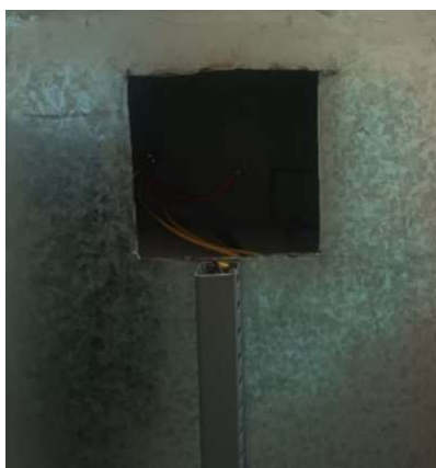
Fig. 51. Corte de 11x11 cm vista posterior de la carcasa externa.
