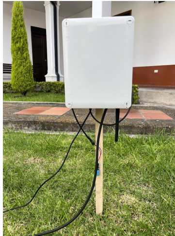
Figura 4.3: Colocación de la caja en la estaca.
