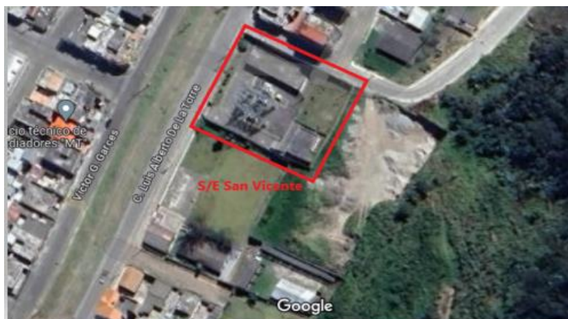
Figura 2. Localización geográfica de la subestación San Vicente.
