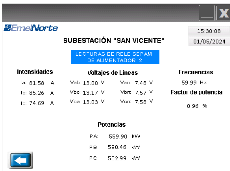
Figura 26. Sub-pantalla de lectura de relés SEPAM de parámetros eléctricos reflejado del Alimentador I2.
