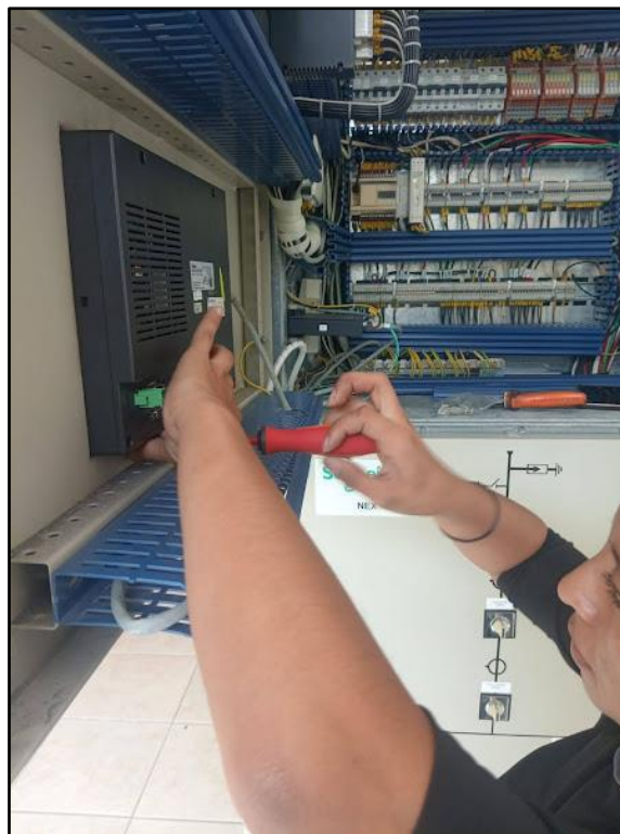
Figura 44. Conexión de alimentación y de señal Ethernet.
