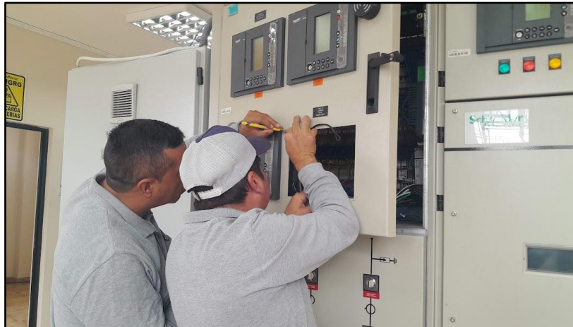
Figura 43. Toma de medidas para montaje de pantalla HMI.
