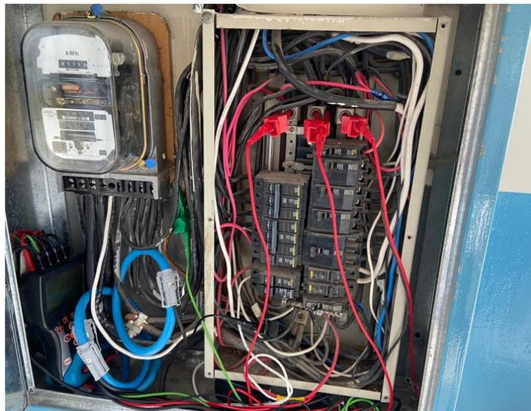
Figura 24: Conexión Analizador de redes MetrelQ4Power a Centro de Carga
