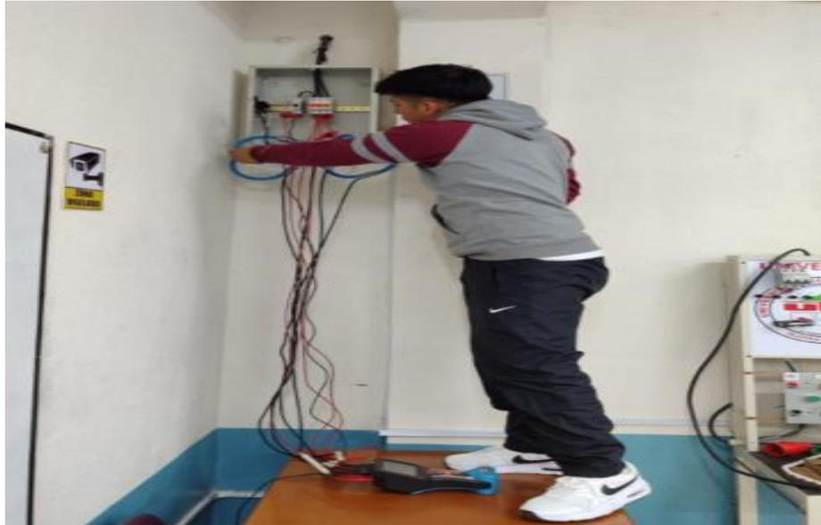
**Anexo 2.** Configuración de conexión del analizador de red
