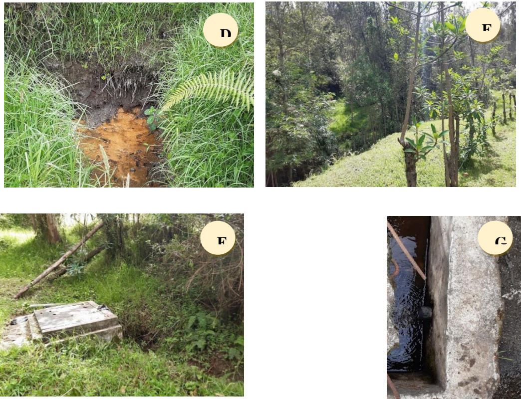
FIGURA 13: D. AFLORAMIENTO DE AGUA E. VISTA DEL CERRAMIENTO DEL ÁREA DONDE SE ENCUENTRAN LAS FUENTES DE AGUA F. TANQUE DE ALMACENAMIENTO G. VISTA DE AGUA QUE INGRESA AL TANQUE.
