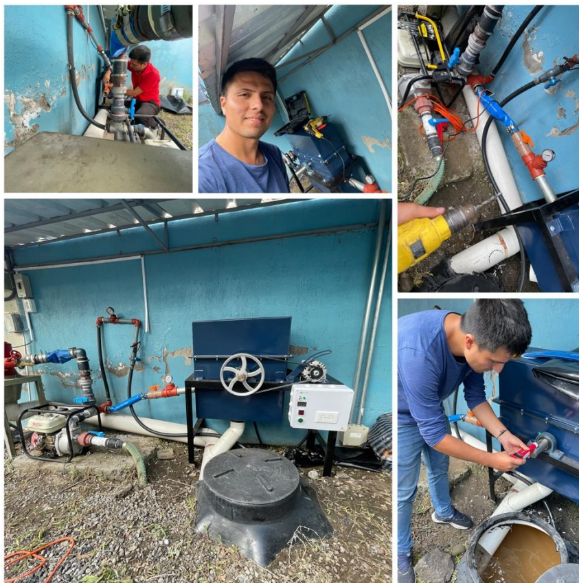
Fig. 33 Montaje del módulo y puesta en marcha.
