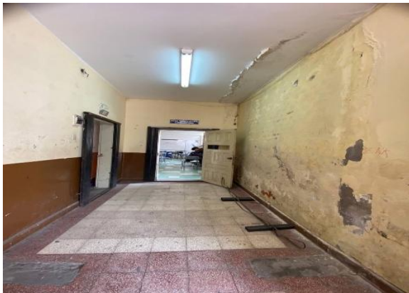
Pasillo para ingresar al aula
