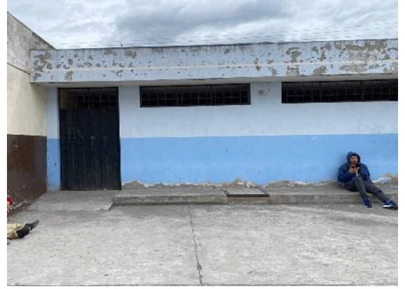
Baño de uso preferencial deshabilitado
