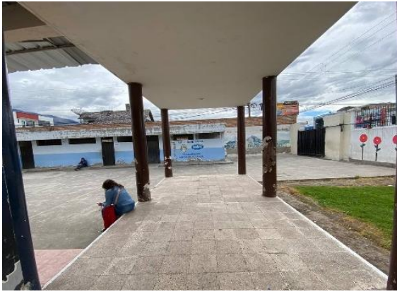
Corredor hacia los baños laterales
