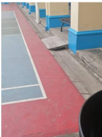
Rampa de Acceso: Cancha principal
