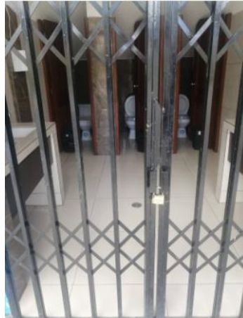
Sanitario canchas deportivas: Vista 2
