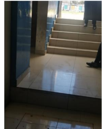
Escalinata: Acceso baño y patio
