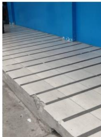
Líneas de seguridad antideslizantes
