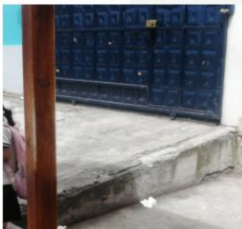
Puerta de Acceso Sur: Vista 1
