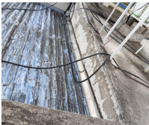
Fig. 33. Perforación y enrutamiento del cableado DC.
