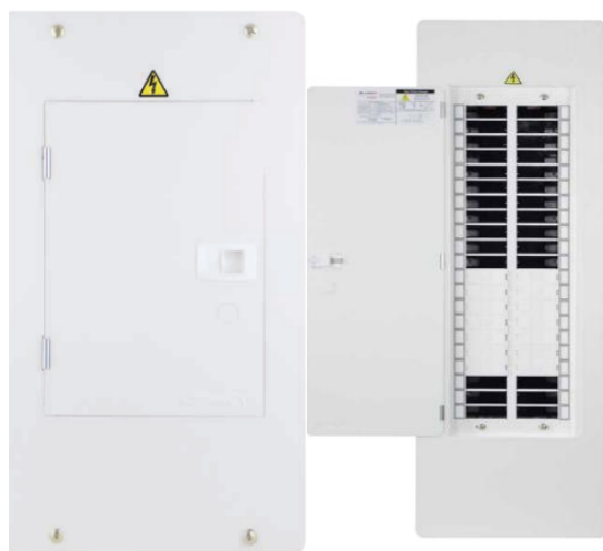
Fig. 22: Tableros de distribución trifásicos.
