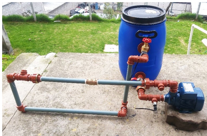
Figura 4.35. Montaje de los componentes
