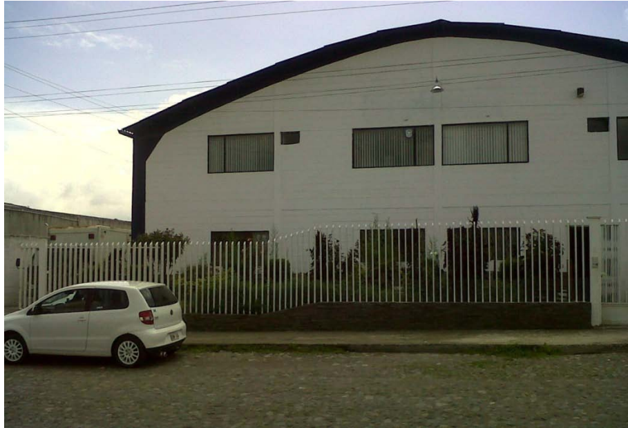
Fachada de la Empresa CHE-QUIM (Matriz Ambato) Foto: Los Autores
