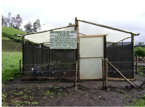
Fotografía 1. Construcción del vivero.
