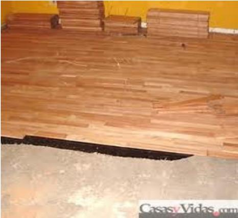
Los pisos flotantes son pisos que flotan, bajo ningún concepto se deben adherir al piso, estos pisos son instalados sobre una capa de poliuretano, la misma que sirve como aislante de sonido y temperatura. Pueden instalarse sobre casi todas las superficies: Vinilo, madera, baldosas y cemento.
