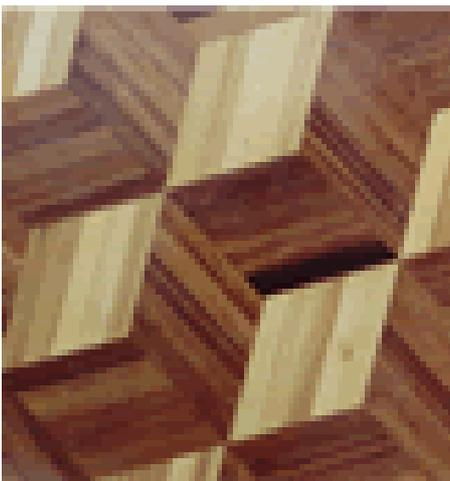
Los pisos de Parquet son los más tradicionales y clásicos entre los diferentes tipos de pisos de madera. Se realiza con tablas finas machimbradas sin tarugar de dimensiones pequeñas, que se ensamblan en el piso formando distintos dibujos geométricos y angulares: cuadrados, rombos, triángulos.
