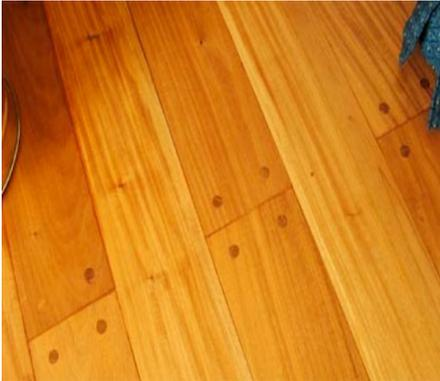
Está compuesto por tablas machimbradas que tienen en cada extremo orificios a través de los cuales se atornillan o se clavan al soporte. Los orificios se tapan luego con tarugos de madera que pueden ser del mismo color de la madera de la tabla o de un color que contraste.
