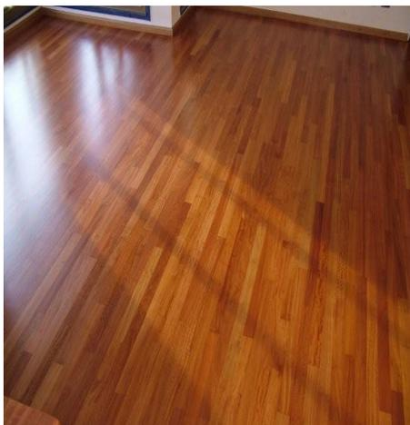
Los pisos entablonados de madera o madera entablonada consisten en tablas o tablillas de madera maciza con sus bordes machihembrados. Esto hace como en otro tipo de configuración de pisos que encajan una con otra formando la superficie mancomunada que constituirá su futuro piso entablonado.
