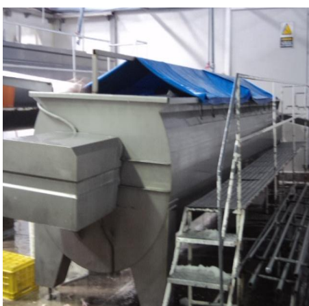
FOTOGRAFÍA 10. Chiller de aves, Noviembre 2009
